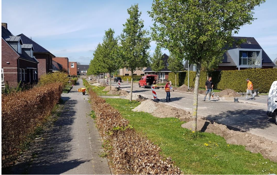
Figuur 8: Grietmansweg ten tijde van afrondende werkzaamheden (woonrijp)
