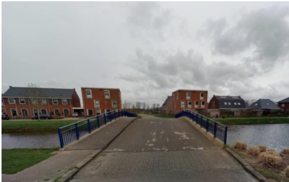
Figuur 9: Brug Holtropslaam
